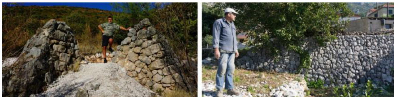
Photo: Les artisans Ivo Antunović et Pero Kukuljica debout près de leurs ouvrages (restes de four à chaux, mur de séparation).
