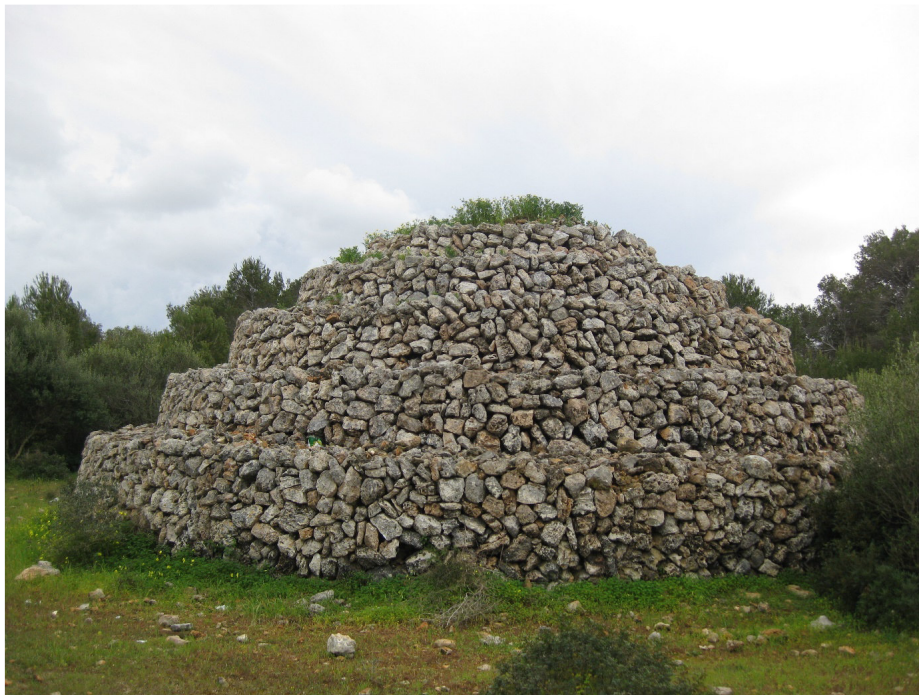
Vista exterior posterior de la Barraca, en el seu estat actual
