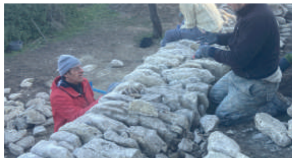
Couronnement vertical clavé chantier de Saignon (84)
