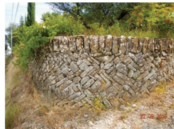
Fig.4 - Mur patrimonial restauré, appareillage oblique dit par certains "à la piémontaise"
