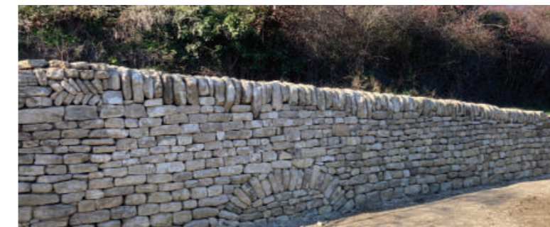
Livraison de l'ouvrage – hauteur de 1.95 m à 1.30 m, longueur 13 m
